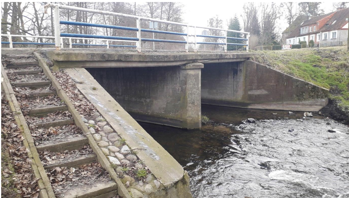
Fot. 1 Widok od strony wody dolnej
