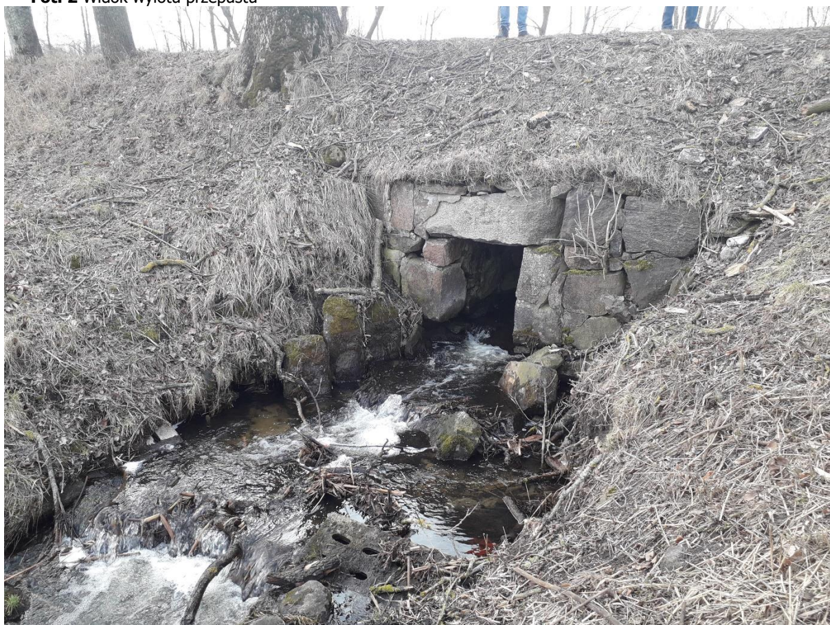
Fot. 2 Widok wylotu przepustu
