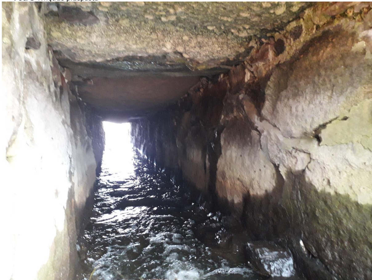
Fot. 3 Wnętrze przepustu
