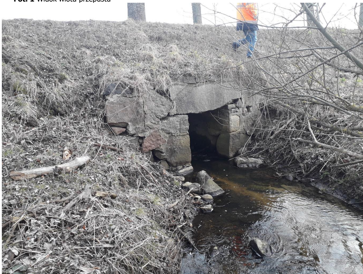
Fot. 2 Widok wylotu przepustu
