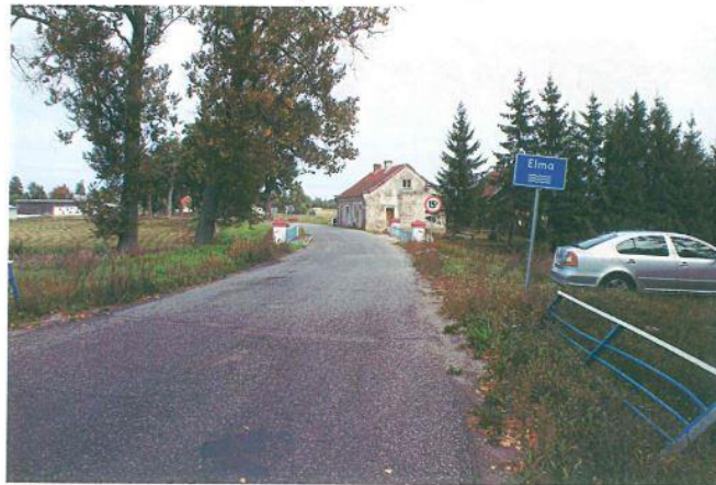
Fot. 2 Widok z boku, od strony górnej wody
