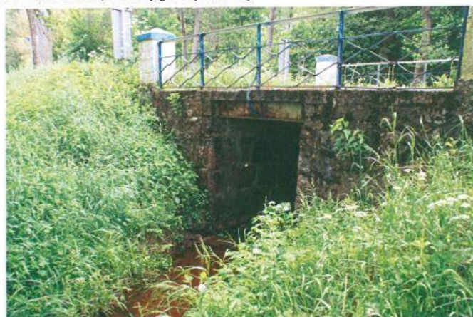
Fot. 3 Widok wzdłuż obiektu od strony Kozina
